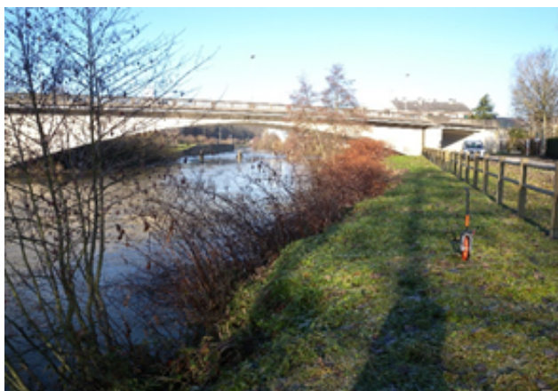
Figure 2. Site avant intervention
