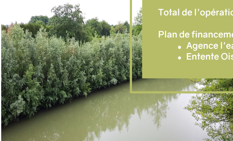
Figure 5. Site après restauration de la berge
