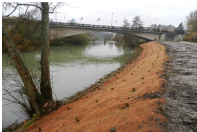
Figure 3. Site après intervention
